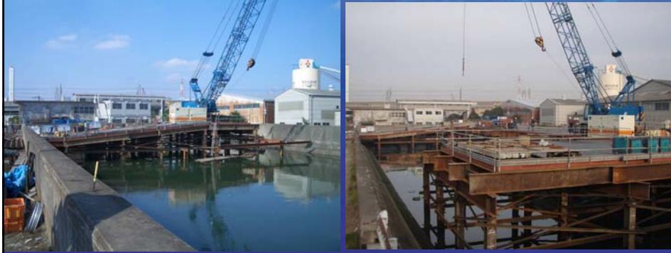
【作業構台の工事状況写真】
