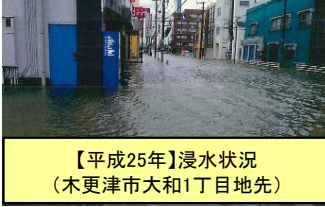
【平成25年】浸水状況 （木更津市大和1丁目地先）
