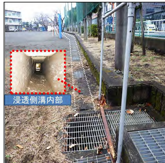
校庭貯留施設
