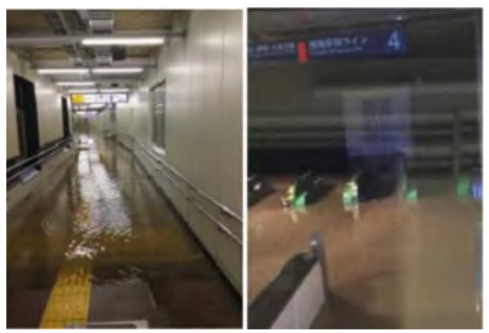
（JR武蔵小杉駅構内内水被害）
