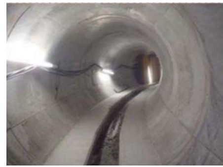
写真2 丸子その1雨水幹線（管内）
