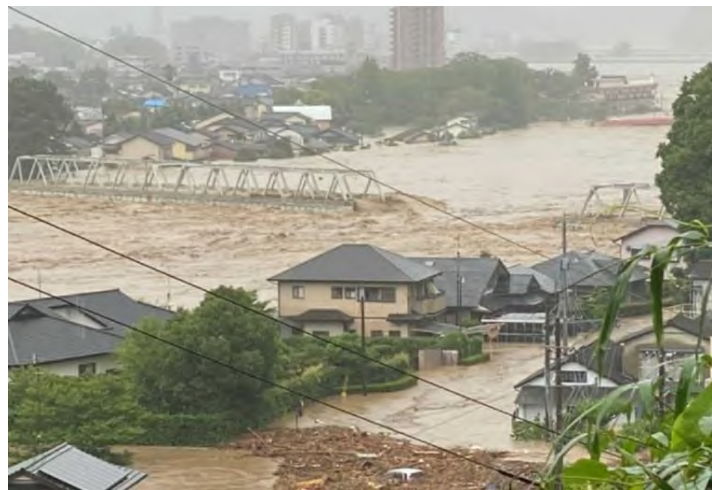
熊本県人吉市 球磨川 (令和2年7月豪雨) 令和2年7月4日
