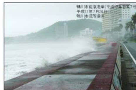
※高潮・高波による被害状況
