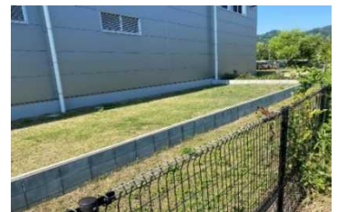
雨水貯留浸透施設 (表面貯留の事例)
