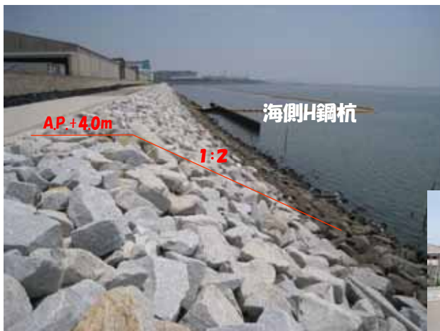
海側H鋼杭(1.2m ピッチ) (工事中)
