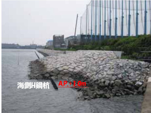
全景(20m完成形)
