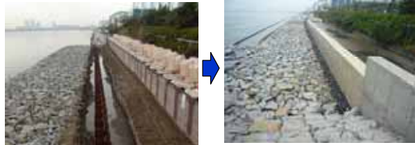
上部工(H鋼杭+鋼矢板:100m)
