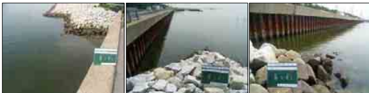
平成 21 年 6 月 12 日(施工前)
