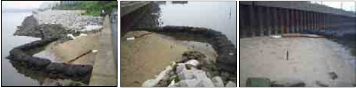
平成 21 年 7 月 22 日(施工後約 1 ヲ月)
