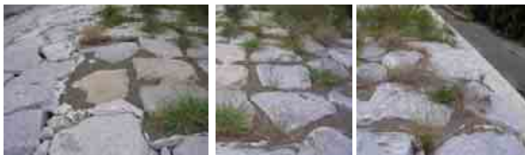
購入砂ゾーン（左が海側）第12回モニタリング調査時
