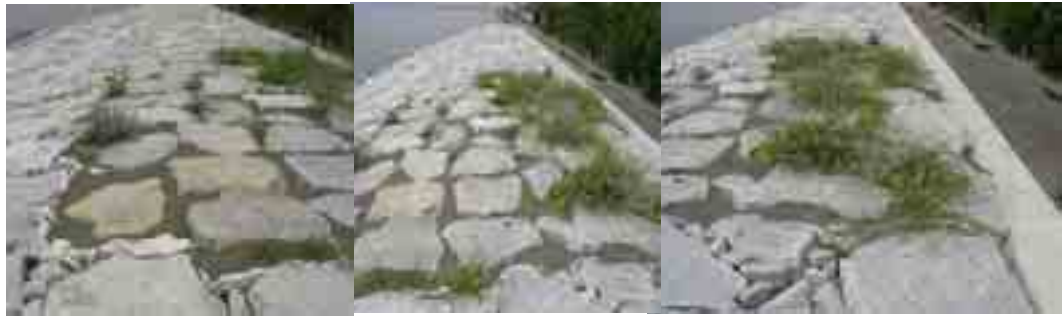
購入砂ゾーン（左が海側）第5回モニタリング調査時
