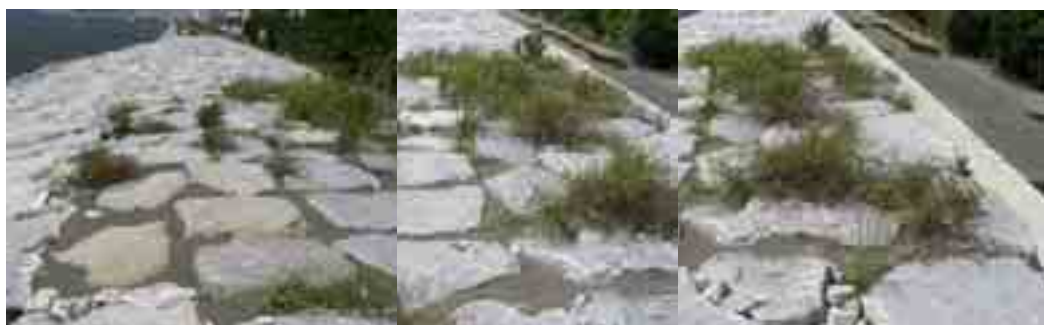
購入砂ゾーン（左が海側）第8回モニタリング調査時
