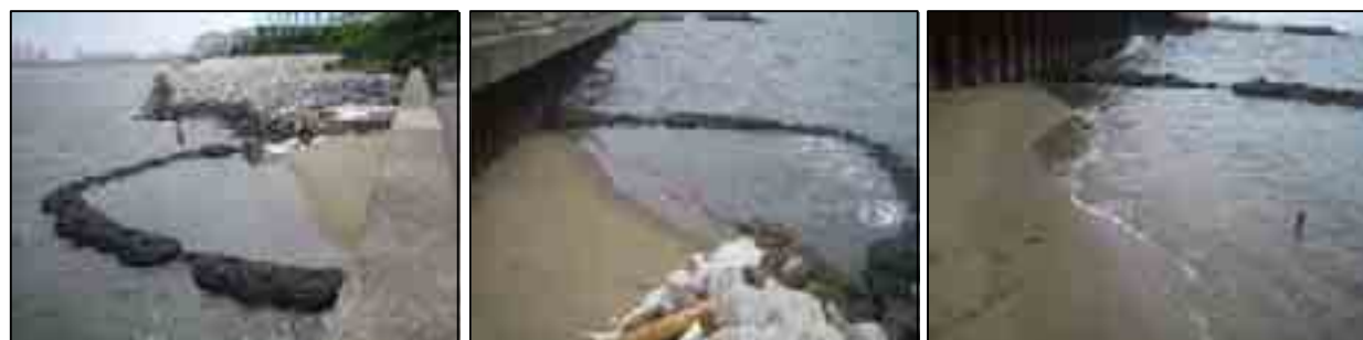
平成 21 年 7 月 10 日(施工後約 2 週間)
