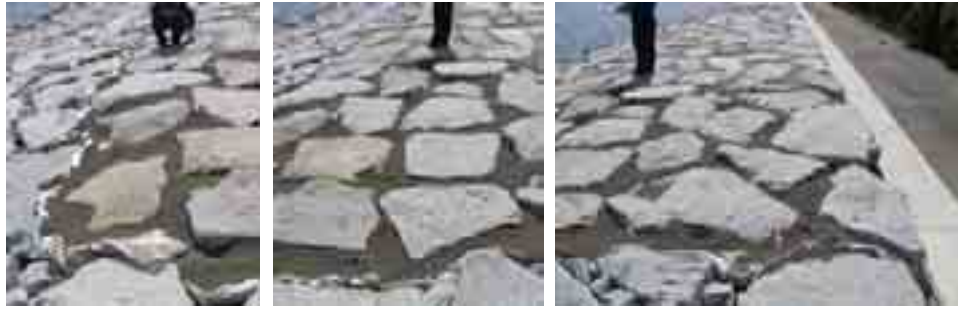
購入砂ゾーン（左が海側）第1回モニタリング調査時
