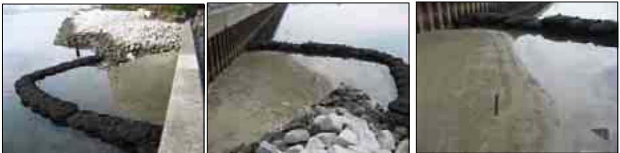
平成 21 年 10 月 14 日(施工後約 3 ヲ月)
