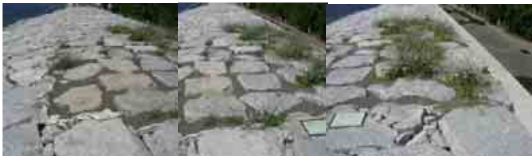
購入砂ゾーン（左が海側）第4回モニタリング調査時
