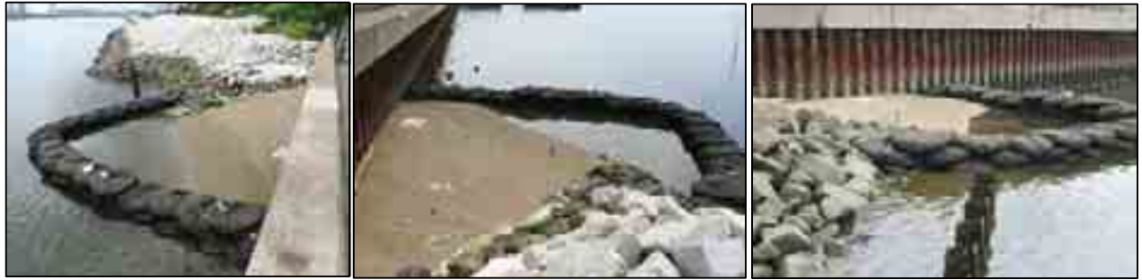
平成 21 年 8 月 8 日(施工後約 1 ヲ月半)
