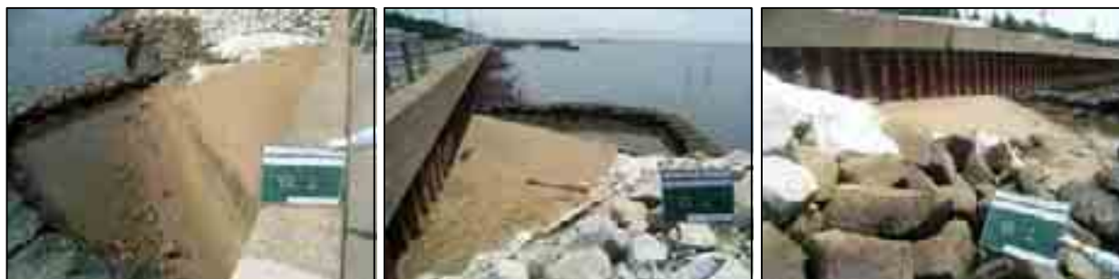
平成 21 年 7 月 7 日(施工直後)
