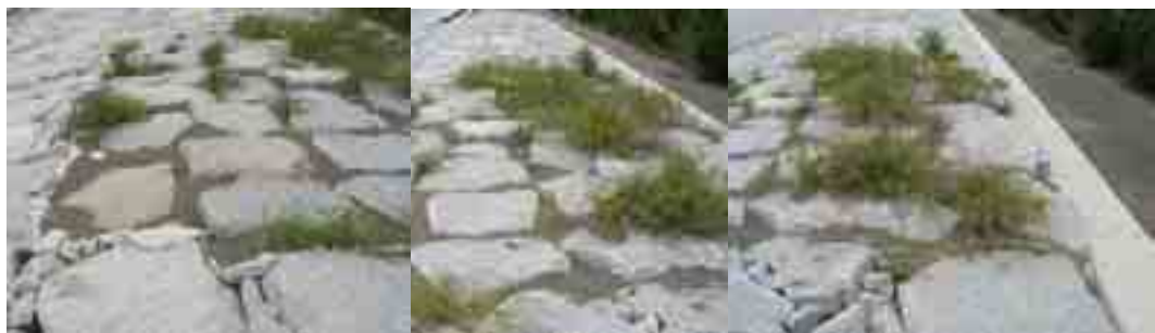
購入砂ゾーン（左が海側）第7回モニタリング調査時
