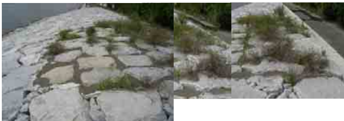
購入砂ゾーン（左が海側）第9回モニタリング調査時
