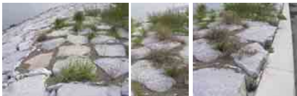
購入砂ゾーン（左が海側）第11回モニタリング調査時
