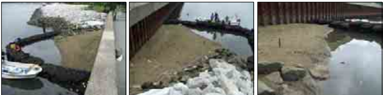
平成 21 年 9 月 2 日(施工後約 2 ヲ月半)
