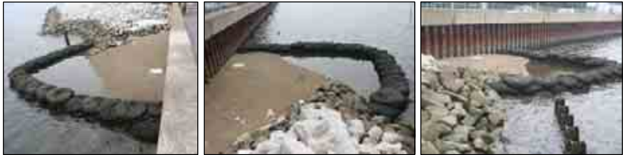
平成 21 年 8 月 22 日(施工後約 2 ヲ月)
