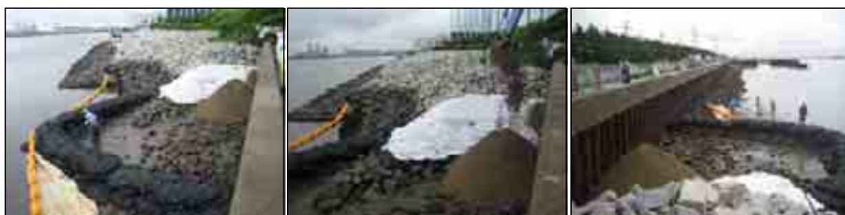
平成 21 年 6 月 22 日(施工時)
