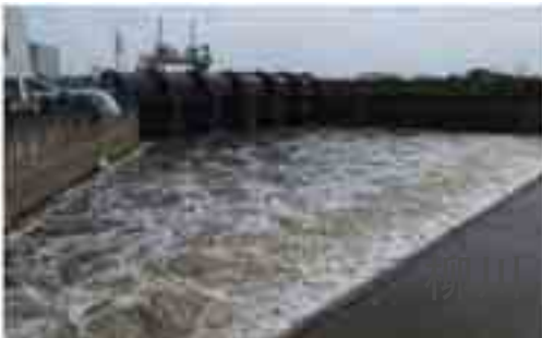
第3立坑(倉松川)越流状況
