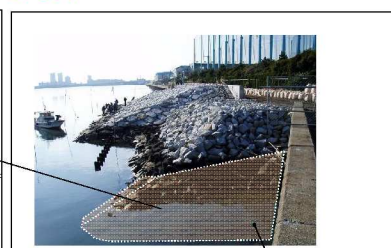
試験場所の状況 投入場所
