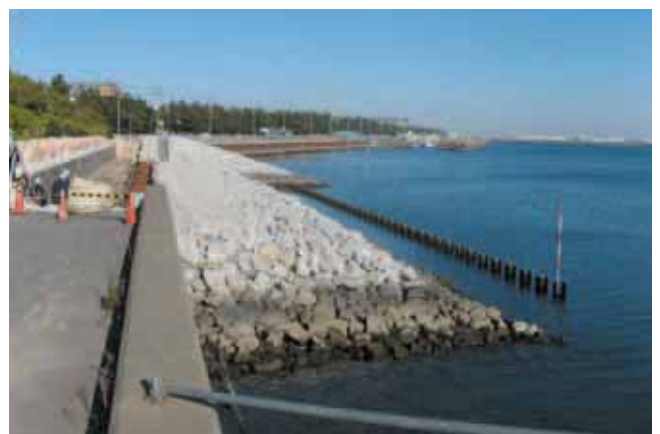
市川市塩浜の護岸の改修
