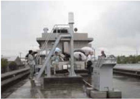
放射能測定棟屋上の見学
