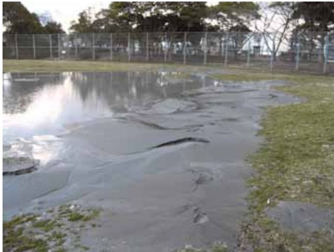
写真 1-3 千葉市美浜区 中磯部公園 (太平洋沖地震による液状化—流動化に伴う多量の噴砂・噴水と沈下)
