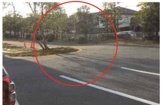
写真1-2 千葉市美浜区磯辺 道路とフェンスの局所的な沈下
