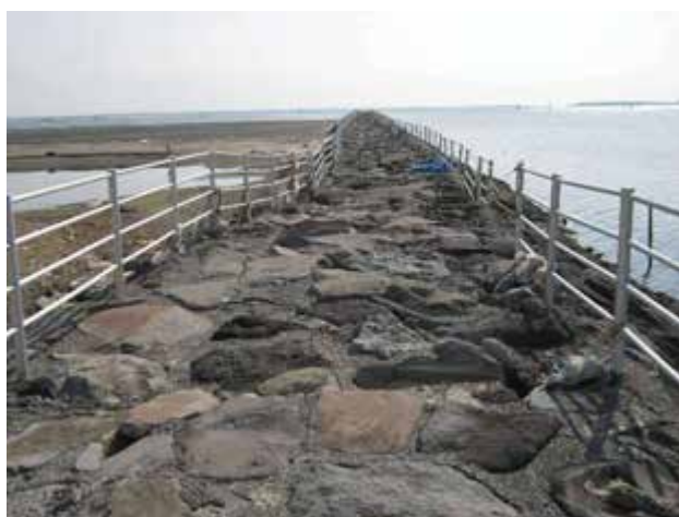
防波堤：左右、上下に大きく歪んだ。
