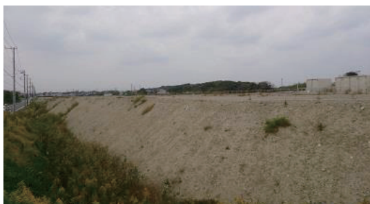
写真1 再生土埋立ての状況
