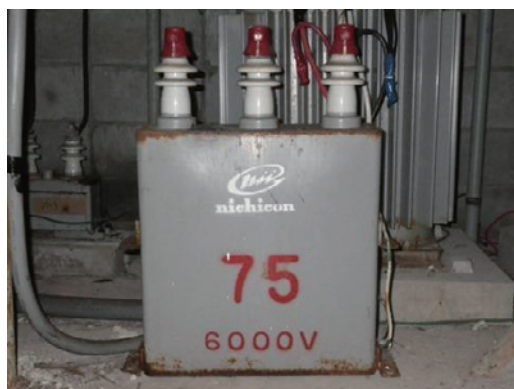
写真 1 PCB が使用された電気機器（左：コンデンサー，右：安定器）
