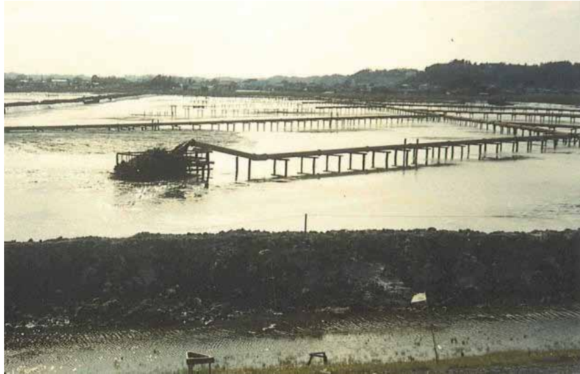
写真 4 サンドポンプによる埋立の例
