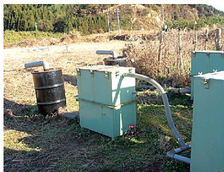
地下にたまっているガス状の汚染物質を吸引する「ガス吸引井戸」（市原市妙香地区）
