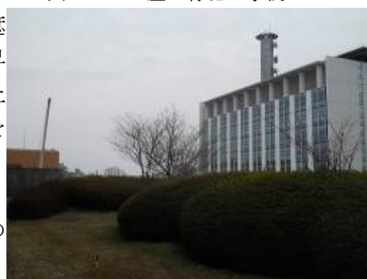
図 3-8 屋上緑化の事例
