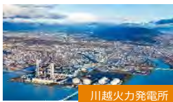
川越火力発電所
