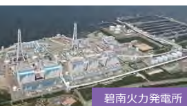
碧南火力発電所
