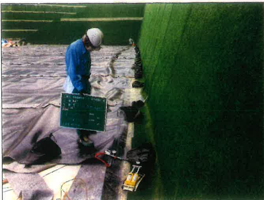
品質管理写真 遮水工(Ⅲ-2-1工区) 遮水シート(上層) 加圧検査 底-9~10/堰-5~10 開始前 0.10Mpa 30秒後 0.10Mpa 2022年 8月25日
