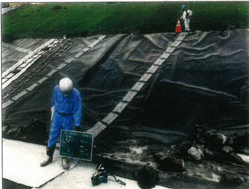
品質管理写真 遮水工(Ⅲ-2-1工区) 遮水シート(上層) 加圧検査 東①-10/東①-11 開始前 0.10Mpa 30秒後 0.10Mpa 2022年 8月25日
