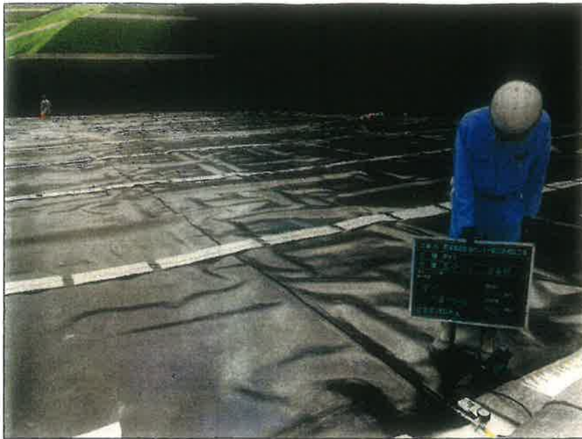
品質管理写真 遮水工(Ⅲ-2-1工区) 遮水シート(上層) 加圧検査 底-11/底-12~13 開始前 0.10Mpa 30秒後 0.10Mpa 2022年 8月25日
