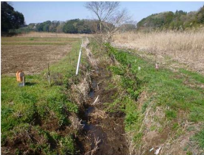
吉田排水路の現況写真 (J78)
