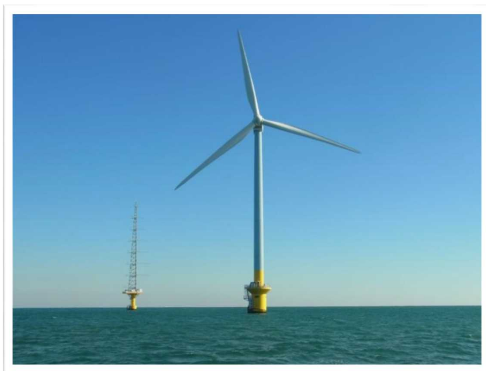
銚子沖に設置されている風況観測タワー（左）と洋上風力発電設備（右）
