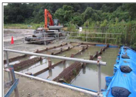
仮設沈砂池の例
