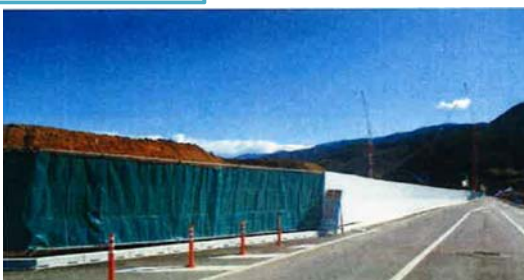
土砂飛散防止ネットフェンス・仮囲いの設置
