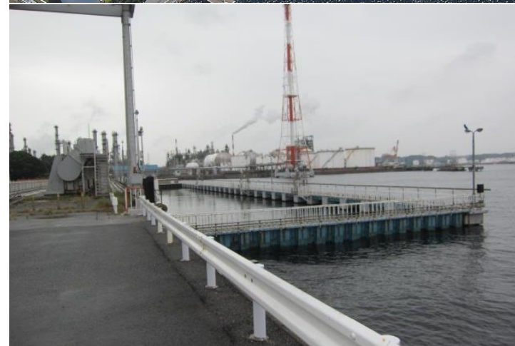
取水設備写真※
