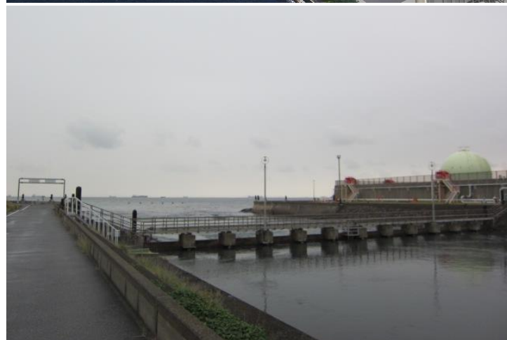
放水設備写真※
