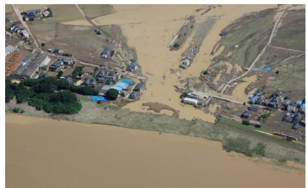
堤防決壊による家屋の流失(鬼怒川)
