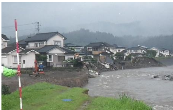
河岸侵食による家屋の倒壊(花月川)
