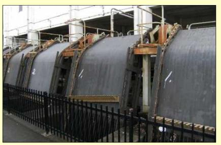
**除塵機**：洪水時に流れ込むゴミを取り除く設備です。老朽化して修繕が困難な機器については、更新を行うこともあります。
