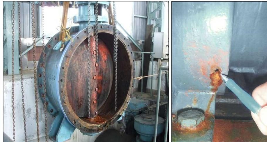
左図：老朽化により不動となった吐出弁。破損した場合は、水の逆流を防ぐことができなくなる恐れがある。右図：腐食により穴があいたポンプ周辺設備の状況。
