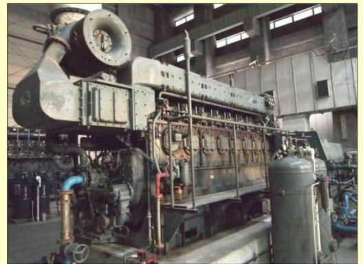
**原動機**：ポンプを回す動力は、主に大型のディーゼルエンジンが用いられます。これらの設備についても、分解整備や消耗品の交換が行われます。車のエンジンと同様にオイル交換も行います。
