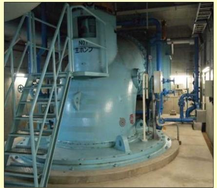
**ポンプ**：巨大な配管の中に回転翼が格納されていて、これを回転して雨水を排水します。排水機場の中心的な設備で、長寿命化計画においては、プロペラの整備などを行います。
