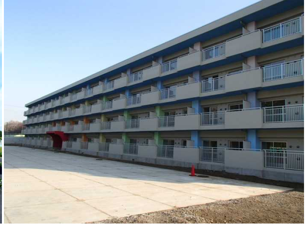
（仮称）鎌ヶ谷四本櫛県営住宅（鎌ヶ谷市）
