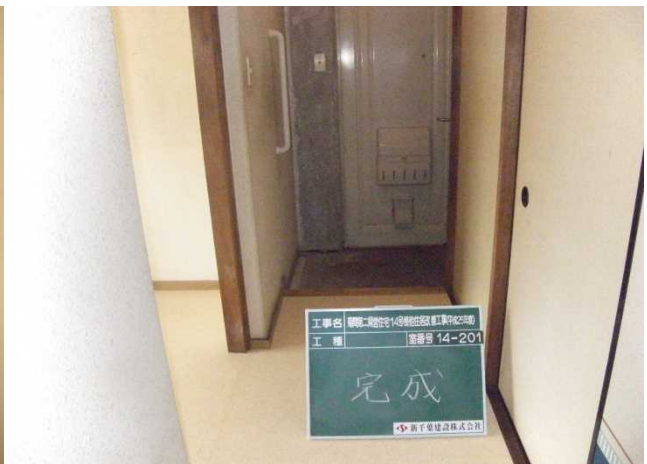
手すり設置、床改修
