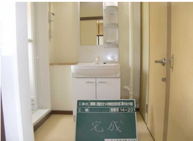
洗面化粧台改修
