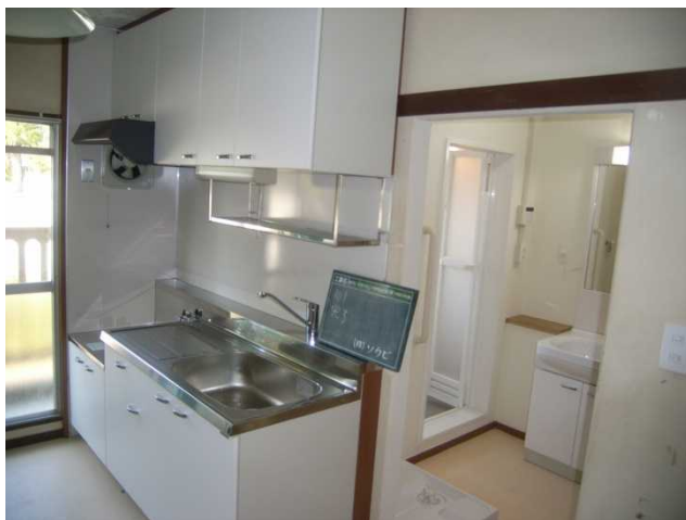
台所流し台改修
