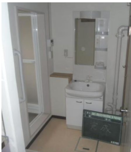
洗面化粧台新設
