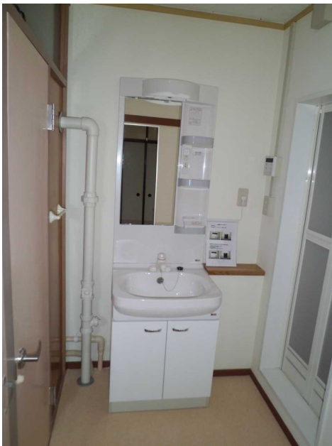
洗面化粧台新設
