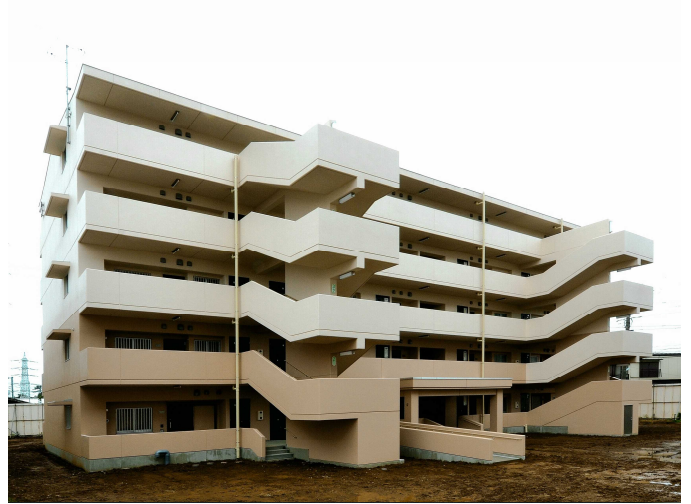
第3期建設工事
