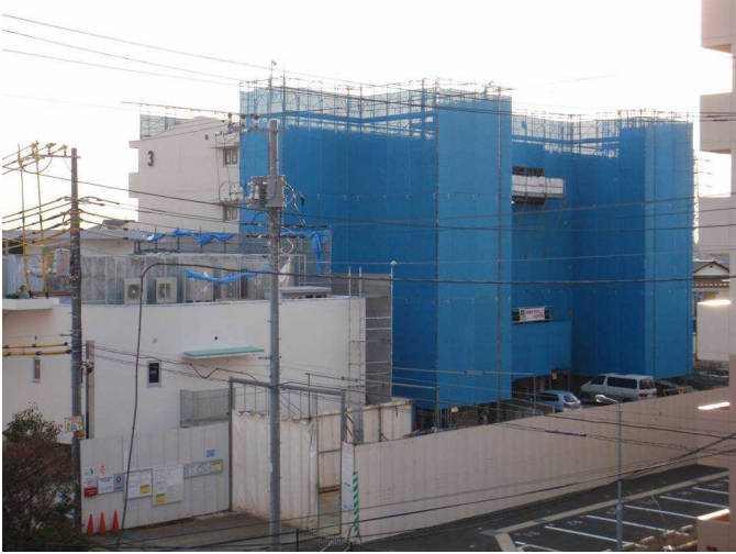
第3期建設工事
