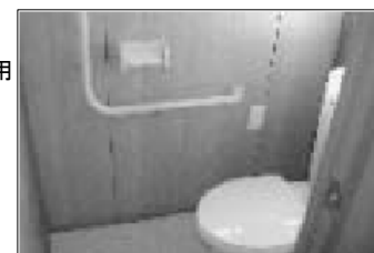
居住性向上・高齢者対応改善例 トイレの水洗化、手摺の設置
