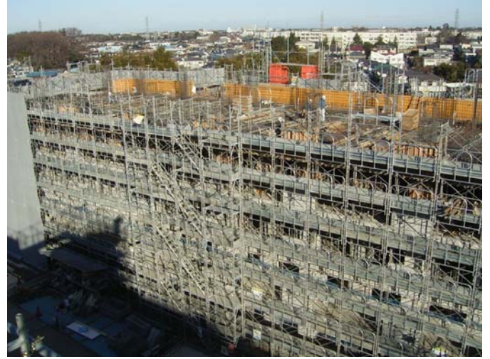
第1期建設工事2号棟
