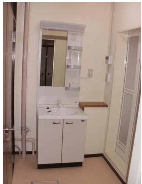
洗面化粧台新設
