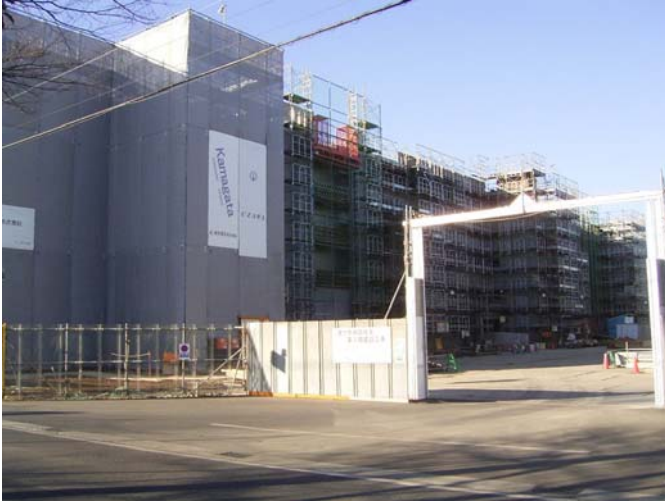
第1期建設工事1号棟
