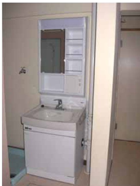
洗面化粧台新設
