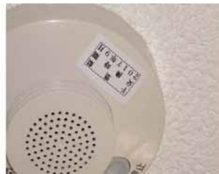
火災報知機設置
