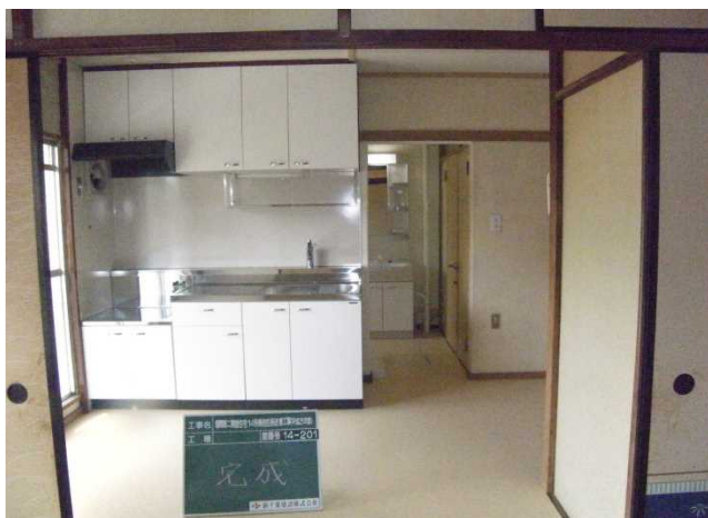
台所流し台改修
