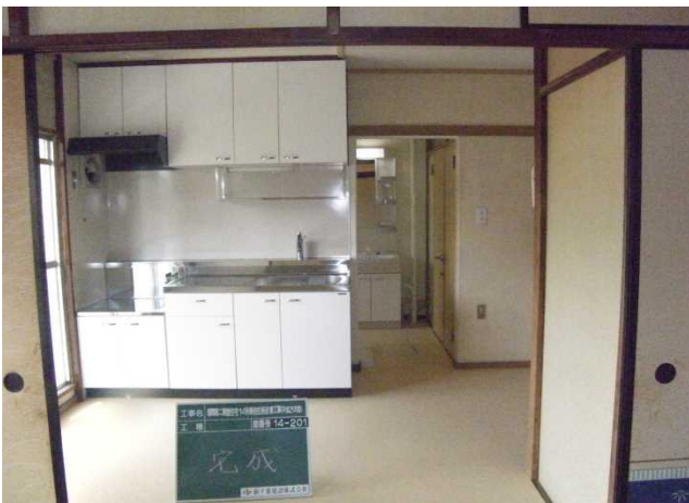
台所流し台改修
