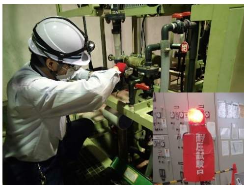
機械設備の整備の様子
