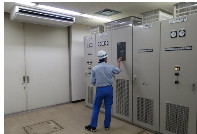
電気設備の点検の様子
