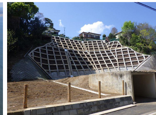
法枠工（千葉市）
