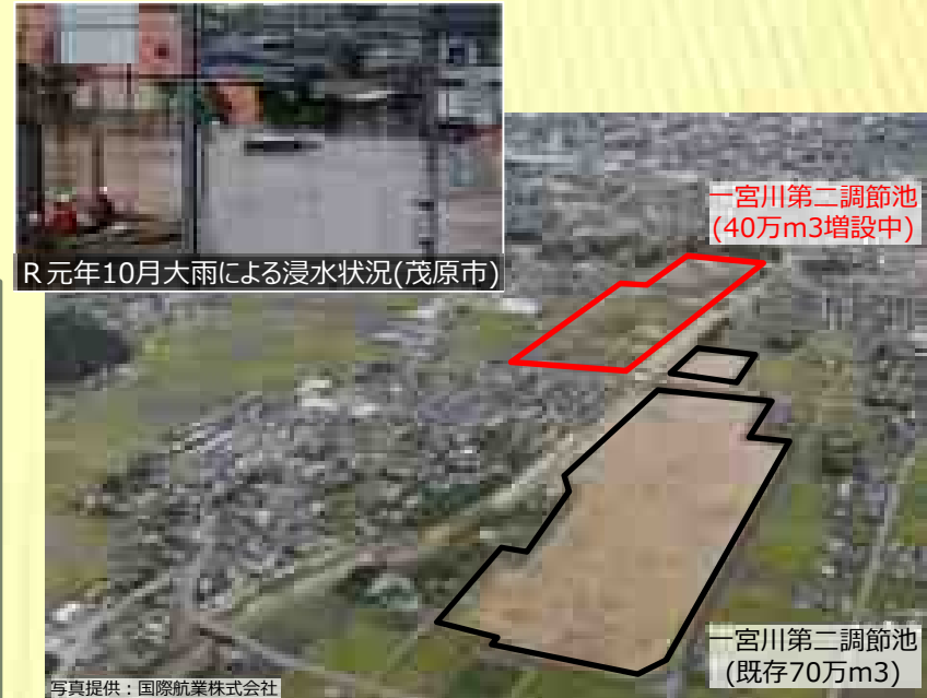
調節池整備（一宮川）
