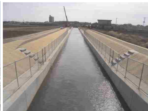
排水路の拡幅・かさ上げ
