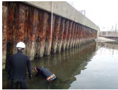
既設直立護岸及び潮間帯生物調査の実施状況
