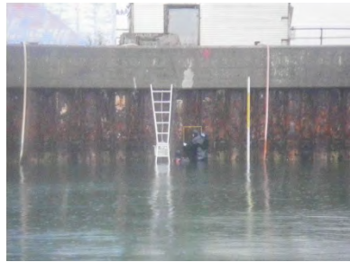
既設直立護岸及び潮間帯生物調査の実施状況
