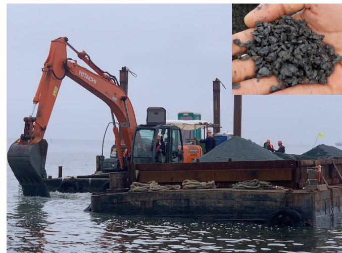
図2 客土 (碎石覆砂) 実施状況 (船橋市漁業協同組合活動グループ)
