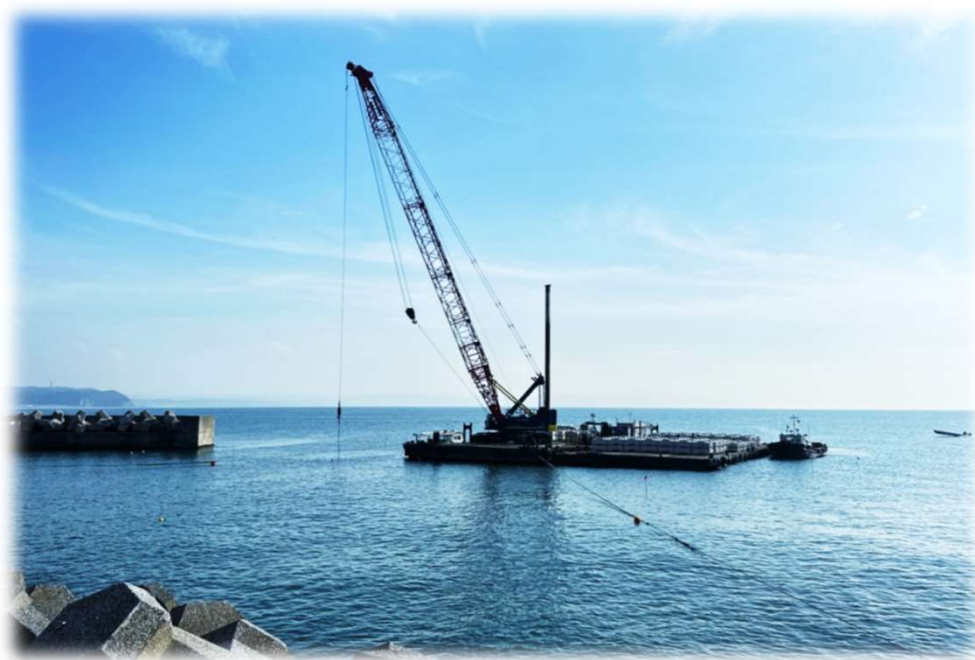
富津漁港（下洲地区） 沖防波堤工事
