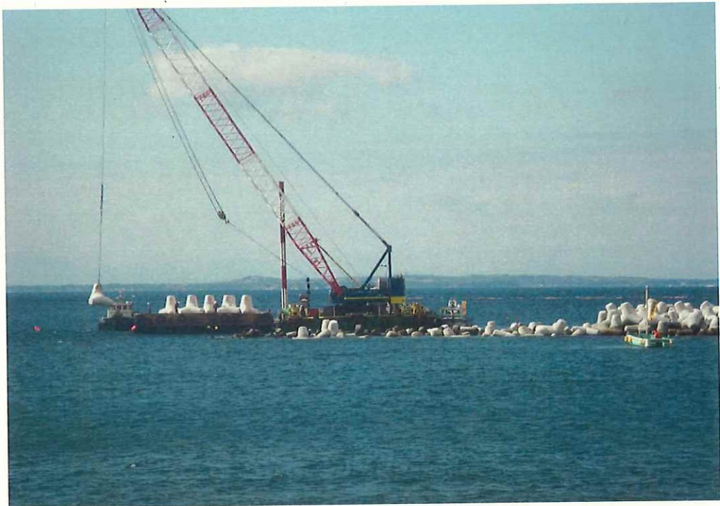
勝山漁港 沖北防波堤工事
