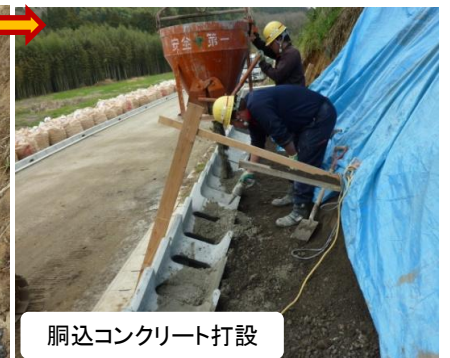
道路法留擁壁施工事例
