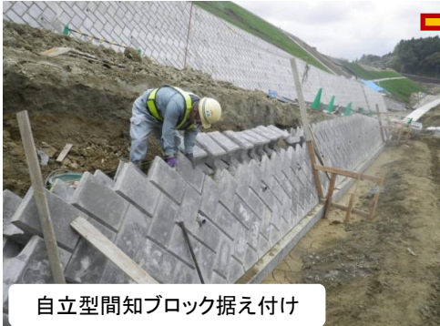
河川護岸施工事例
