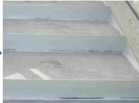
蹴上げ部補修後
