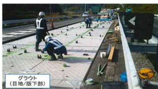
中部地区/国道 / 沈下対策・急速施工
