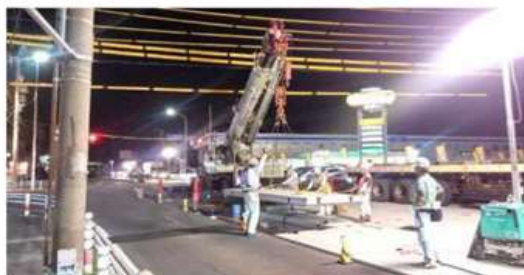
中部地区/幹線交差点 / 高耐久・急速施工
