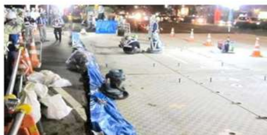
東北地区/幹線交差点 / 液状化陥没対策・急速施工
