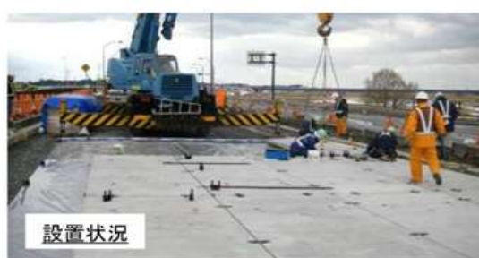
北陸地区/ボックスカルバート埋設箇所 / 沈下対策
