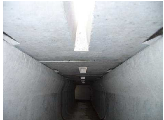
写真2 敷設後U字溝内部
