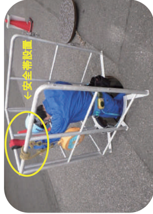
技術（製品）の施工状況
