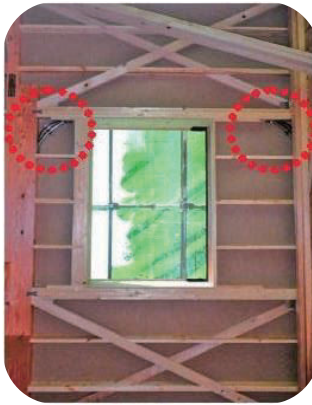
BOSHIN(ボウシン)設置完了。
