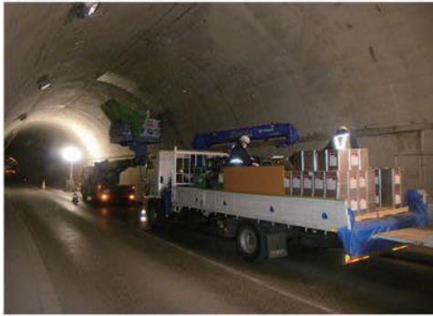
道路トンネル施工状況
