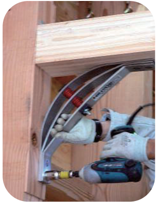
M-12 90mm～100mmのコーチスクリューボルト4本でBOSHIN(ボウシン)を縫い設置。
