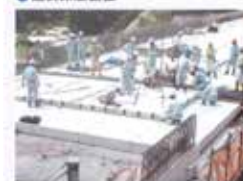
⑤ 伸縮装置設置
