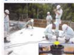
④ 延長床版設置
