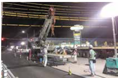
PRC版施工状況
