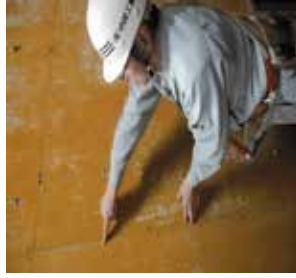
パネルの目違いを直したときの写真
