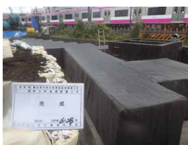
シートの敷設と設置完了
