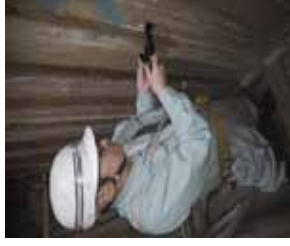
パネルの栈木の中央に45の釘を打って釘の頭にフラットキーパーを引っ掛けて調整している写真
