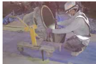
グラウト注入状況
