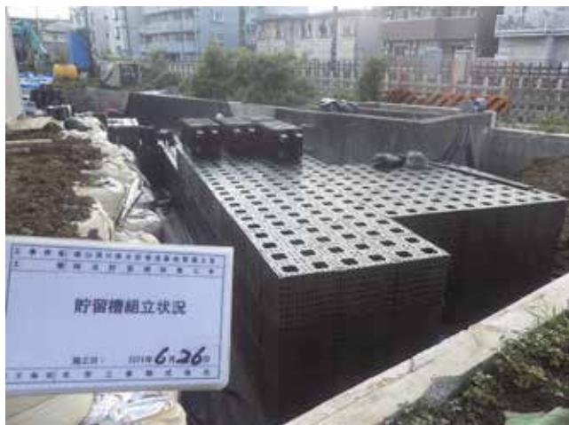
貯留槽組立状況
