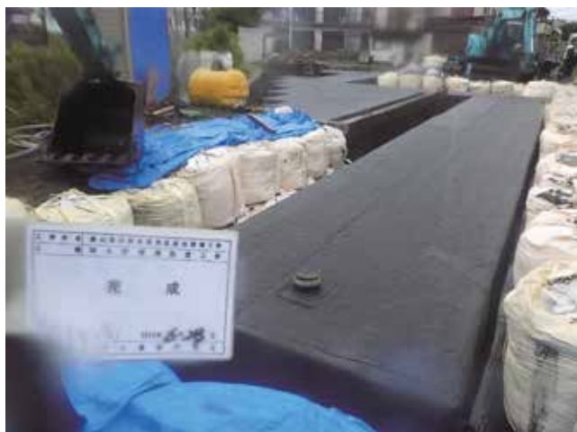
シートの敷設と設置完了
