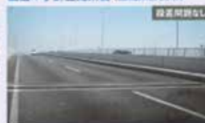
国道4号 針生高架橋（福島県郡山市）
