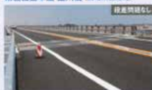
常磐自動車道 錦川橋（宮城県宮城町）
