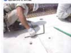
③ コッター式継手継付中
