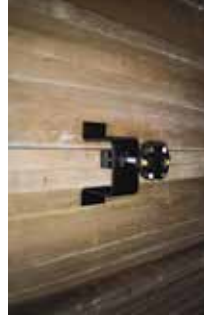
パネルの目違いを直したときの写真
