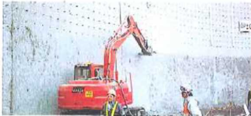
1.8m18トンクレーン取付専用架台取付ハンマー
