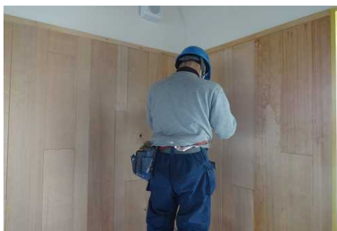
※施工時 刷毛・ローラーで施工
