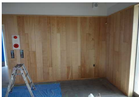
※施工後 クリア仕上げ
